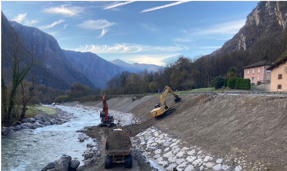
Photocredit_LP@GdC: Uferbefestigungsarbeiten in Sorte
