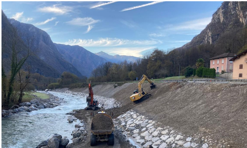
Photocredit_LP@GdC: Lavori di arginatura a Sorte
